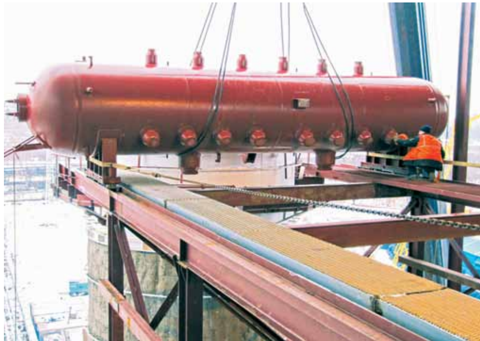
Монтаж барабана котла-утилизатора ПГУ-190 МВт Новомосковской ГРЭС
