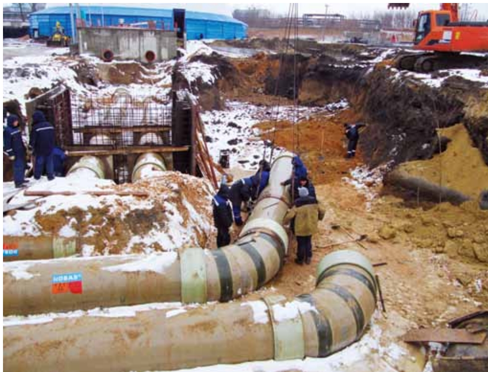
Прокладка водоводов оборотного водоснабжения между градирней и главным корпусом ПГУ
