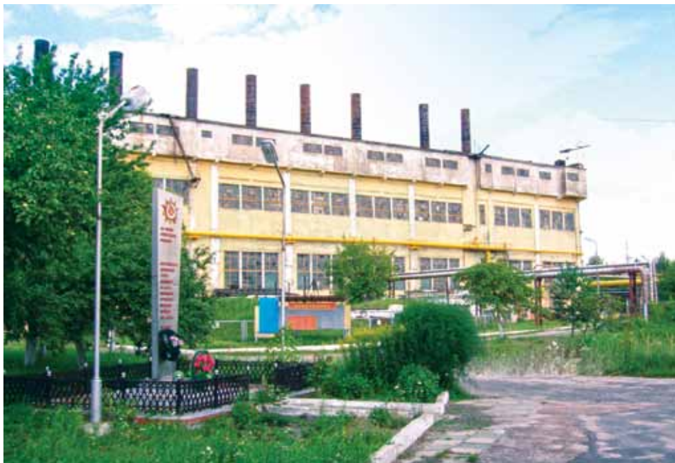
Главный корпус Брянской ГРЭС
