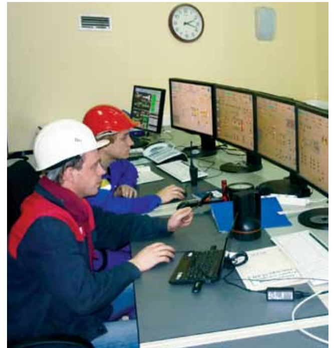
Настройка оборудования ГТУ
