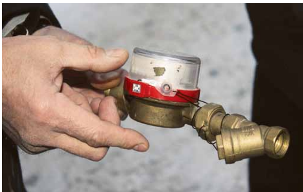
Пломба с антимагнитным индикатором на приборе учета горячей воды
