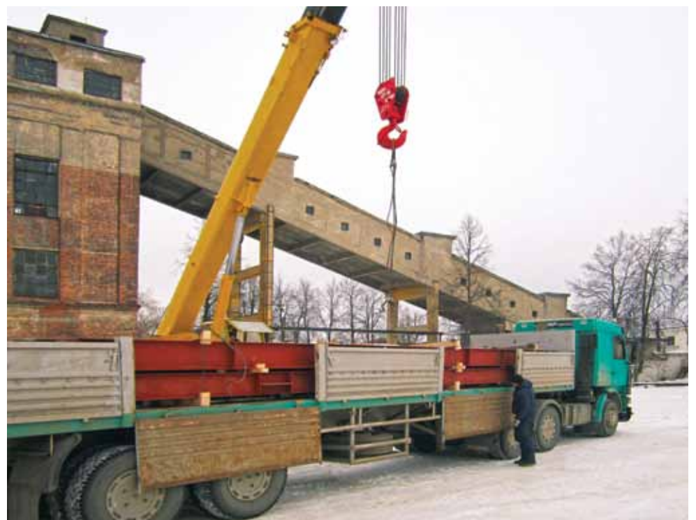
На площадку привозят оборудование для строительства ПГУ на Алексинской ТЭЦ
