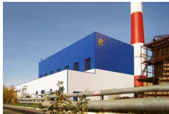
Западная котельная Белгородской ТЭЦ
