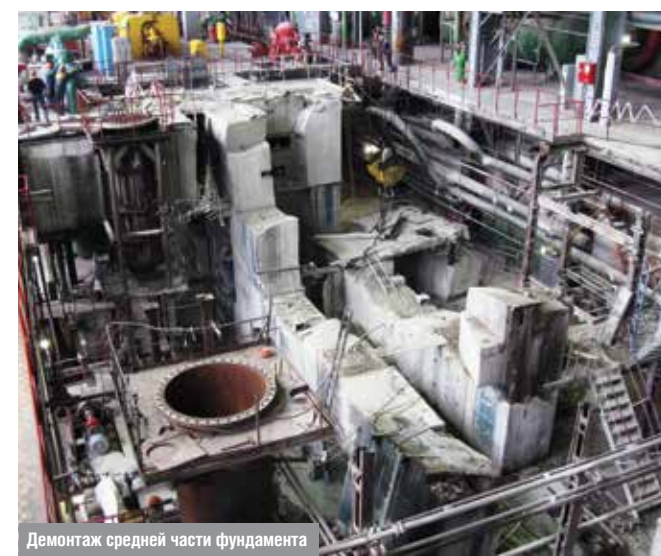
Демонтаж средней части фундамента
