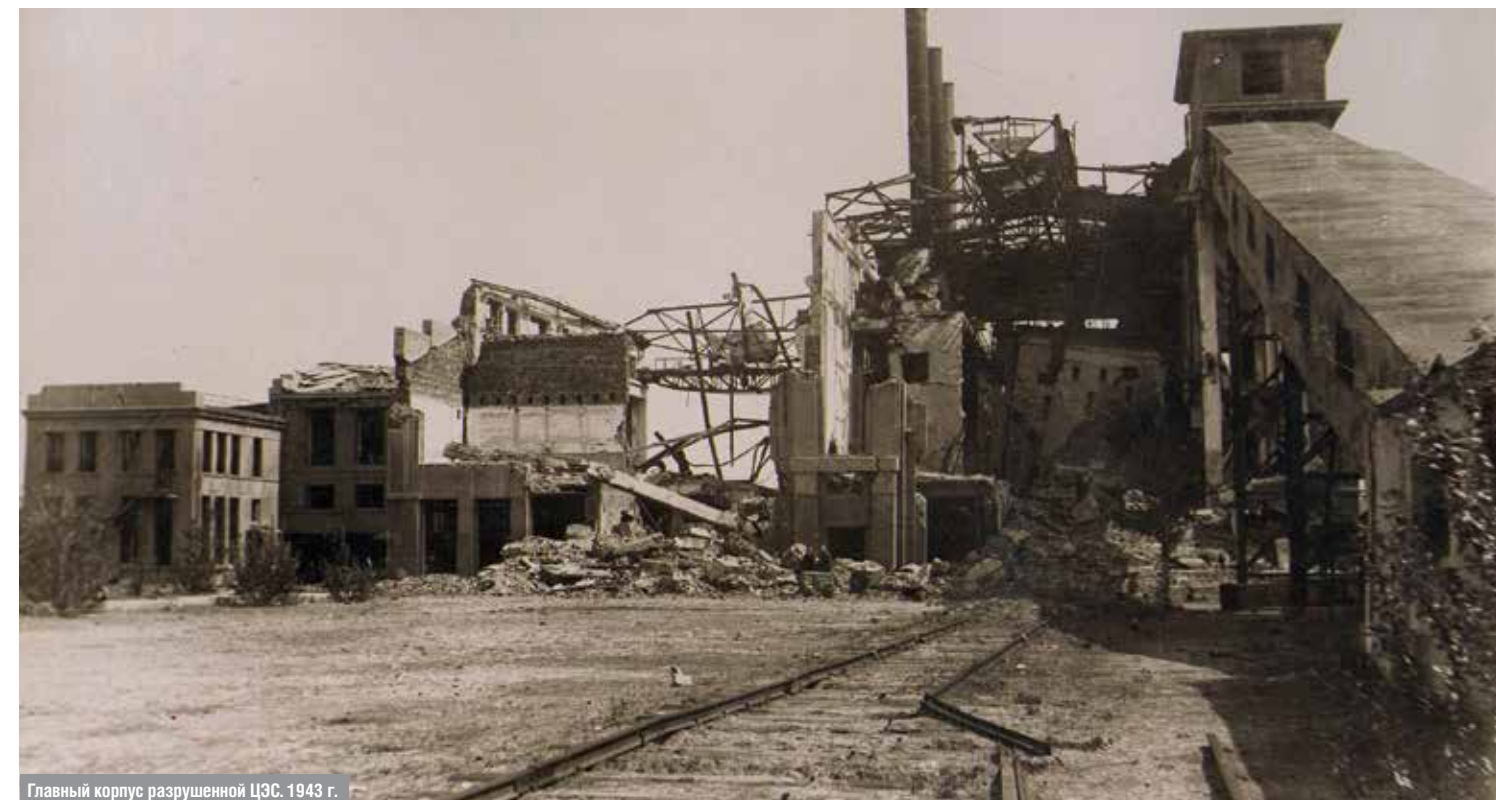
Главный корпус разрушенной ЦЭС. 1943 г.
