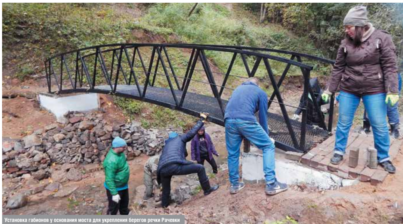
Установка габионов у основания моста для укрепления берегов речки Рачевки
