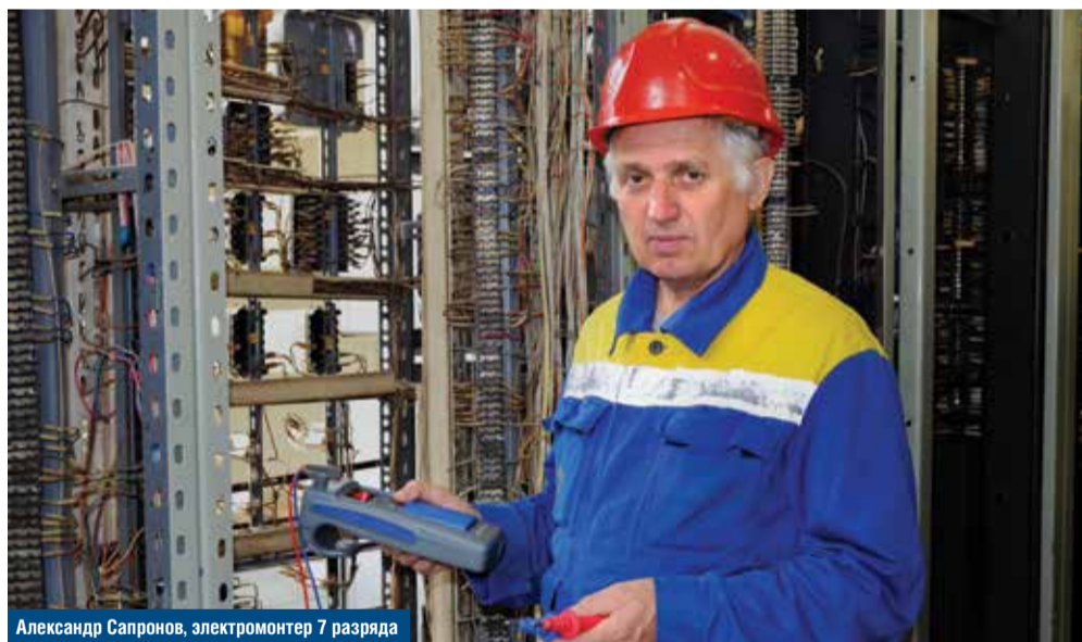
Александр Сапронов, электромонтер 7 разряда
