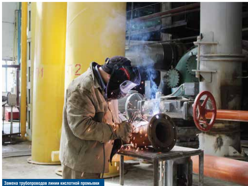
Замена трубопроводов линии кислотной промывки
