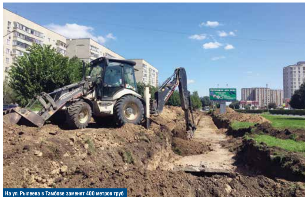
На ул. Рылеева в Тамбове заменяют 400 метров труб
