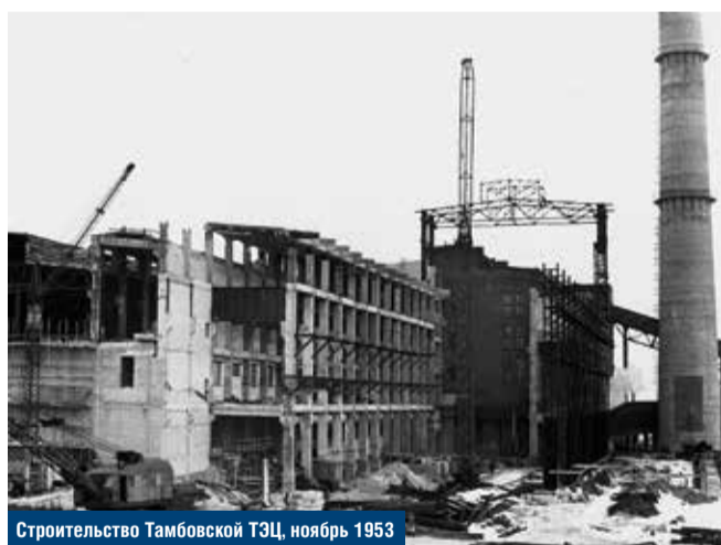
Строительство Тамбовской ТЭЦ, ноябрь 1953
