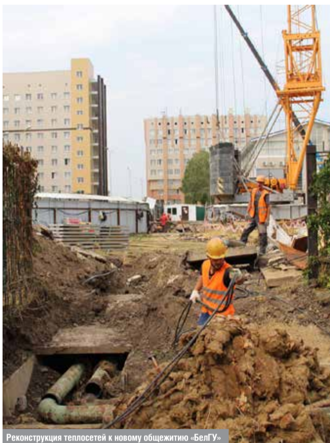
Реконструкция теплосетей к новому общежитию «БелГУ»
