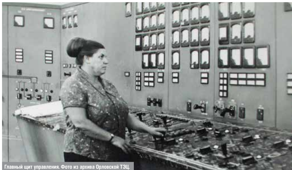
Главный щит управления. Фото из архива Орловской ТЭЦ.
