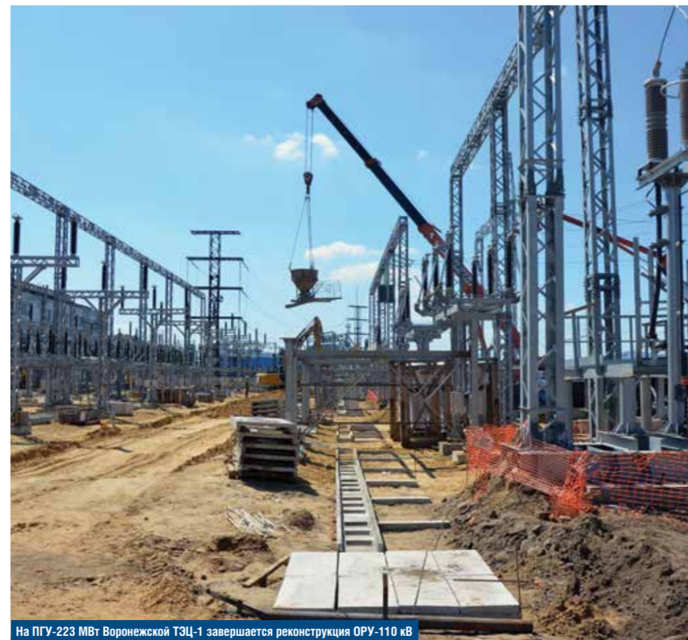
На ПГУ-223 МВт Воронежской ТЭЦ-1 завершается реконструкция ОРУ-110 кВ
