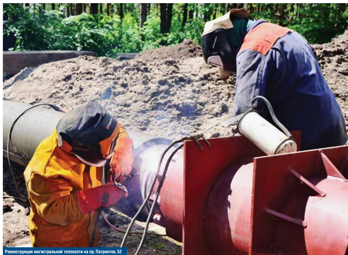
Реконструкция магистральной теплотрассы на пр. Патриотов, 52
