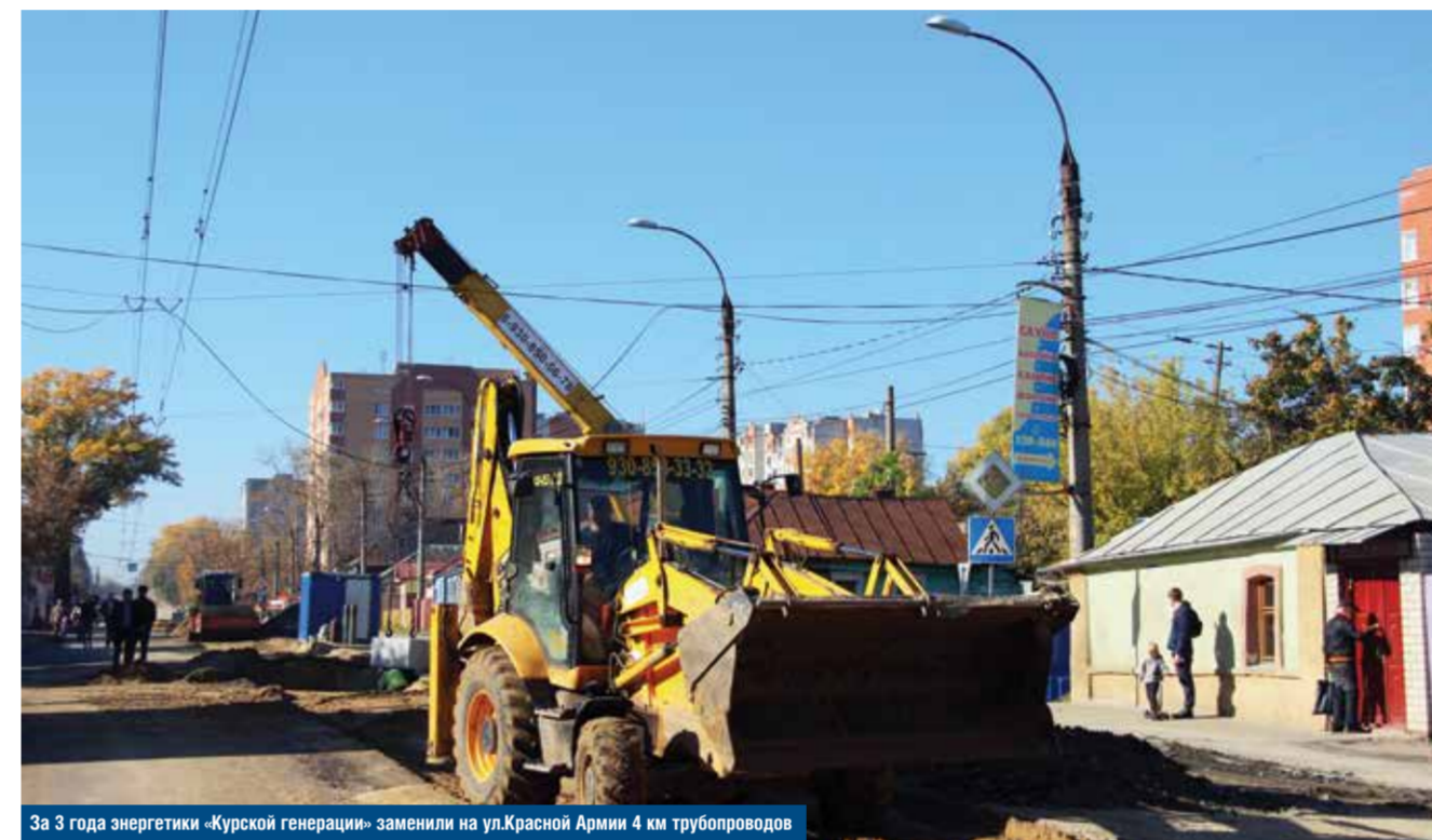
За 3 года энергетики «Курской генерации» заменили на ул.Красной Армии 4 км трубопроводов
