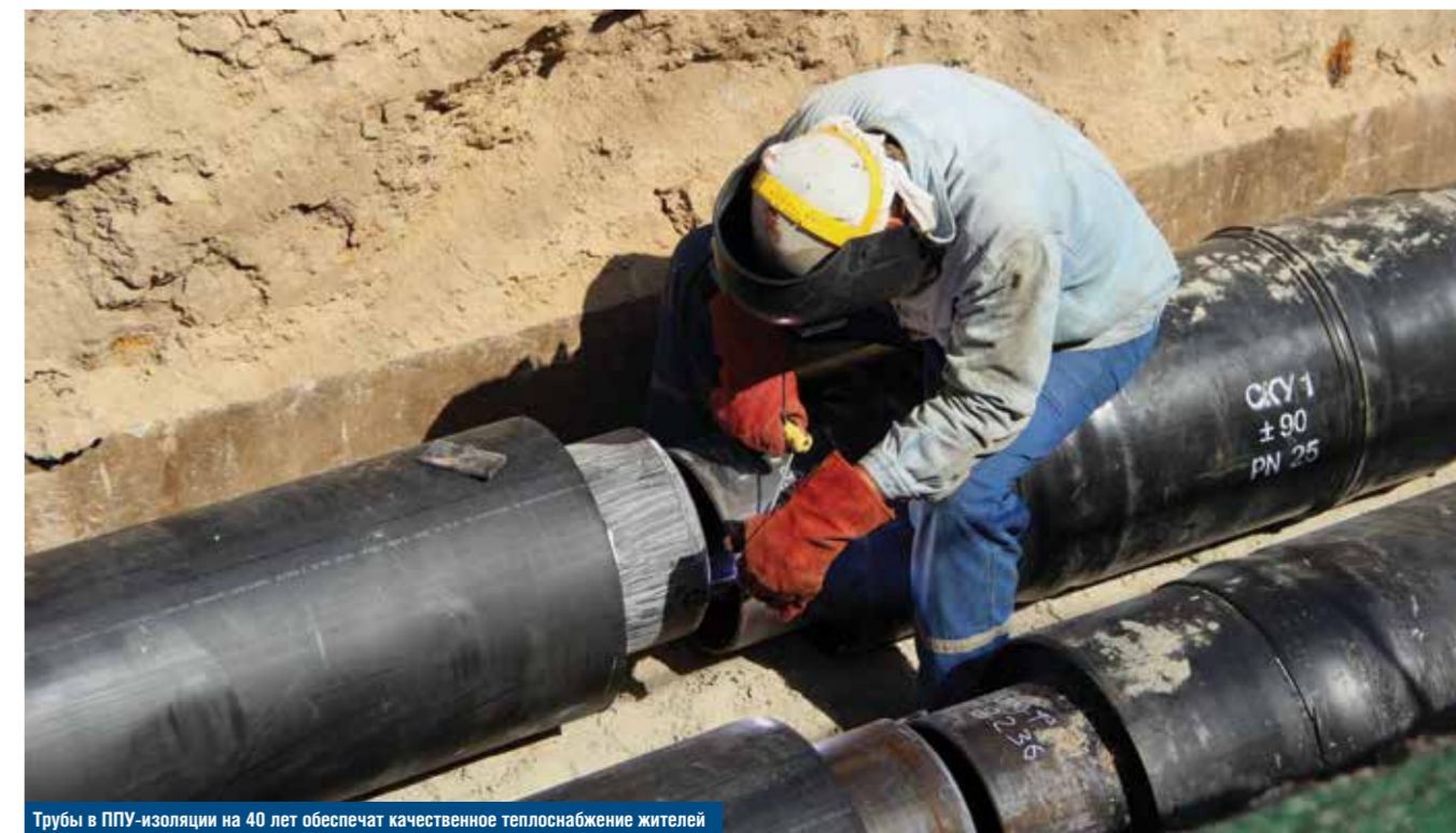
Трубы в ППУ-изоляции на 40 лет обеспечат качественное теплоснабжение жителей
