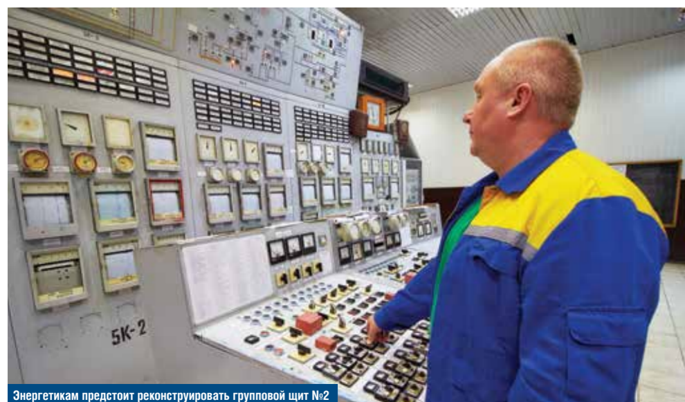
Энергетикам предстоит реконструировать групповой щит №2
