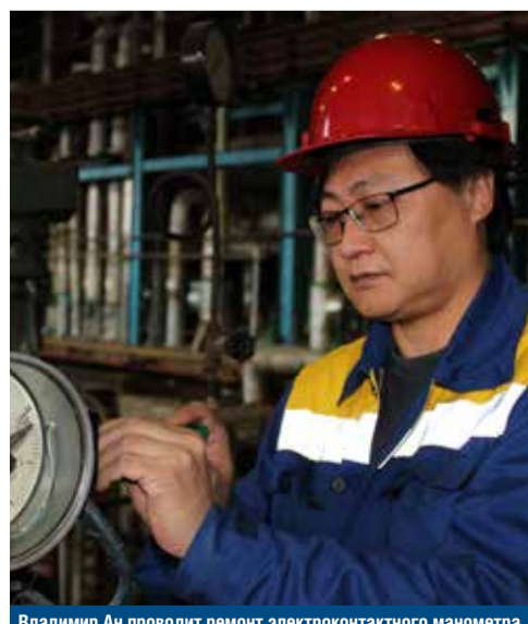
Владимир Ан проводит ремонт электроконтактного манометра
