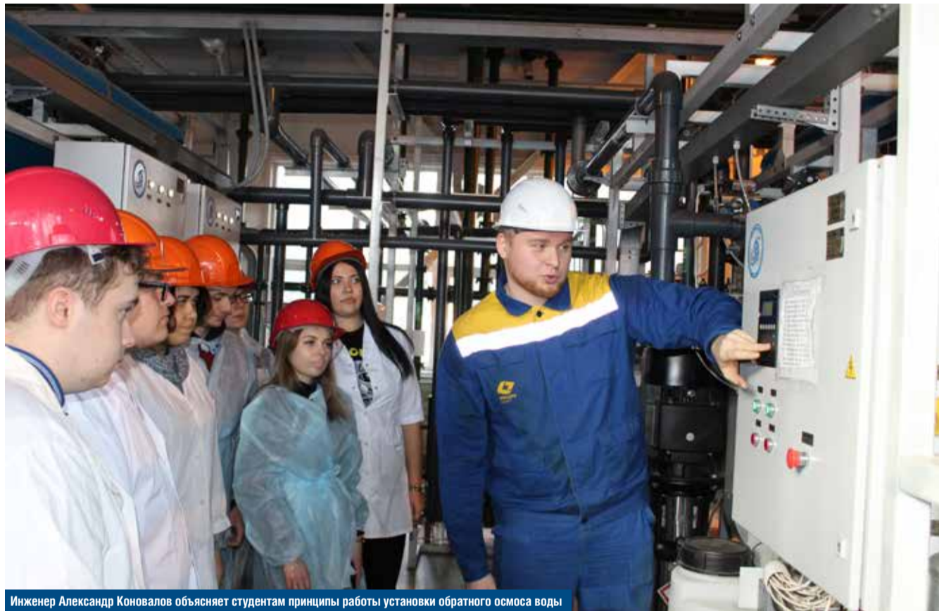
Инженер Александр Коновалов объясняет студентам принципы работы установки обратного осмоса воды
