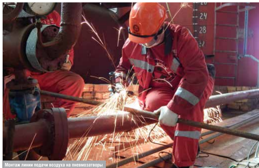
Монтаж линии подачи воздуха на пневмозатворы
