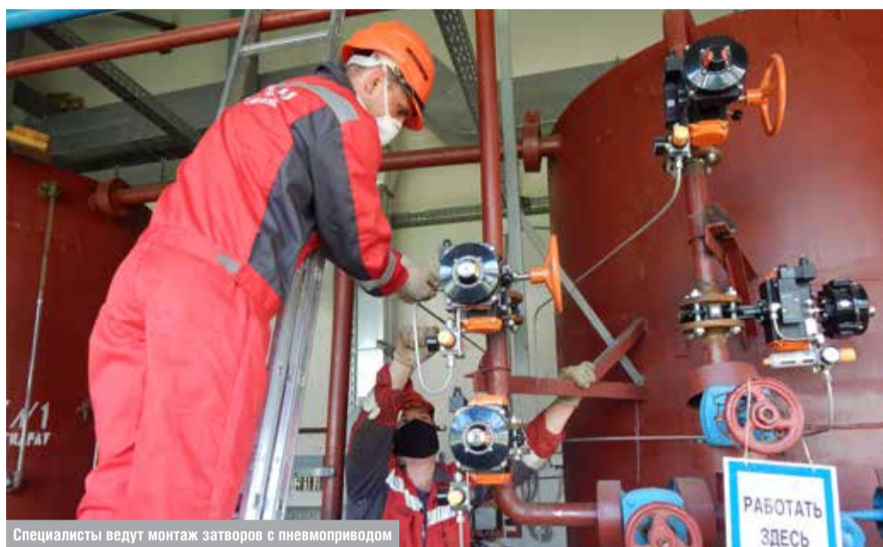
Специалисты ведут монтаж затворов с пневмоприводом
